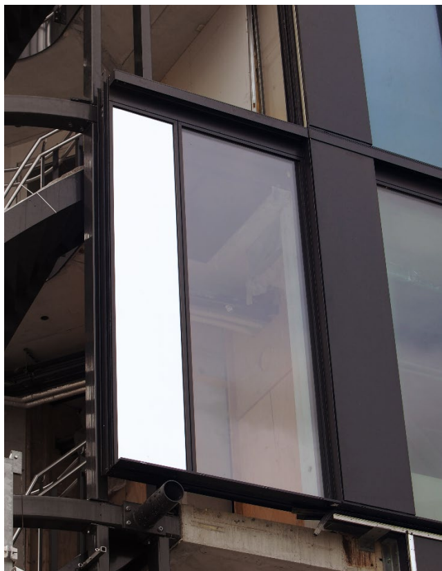
Afbeelding 2: De gevelelementen met vaste beglazing van functioneel isolerend glas werden gerealiseerd met een speciaal ontwerp op basis van het standaard gevelsysteem HUECK Trigon Unit L. De elektronisch gestuurde panelen werden achteraf gemonteerd. (Bron: HUECK)
