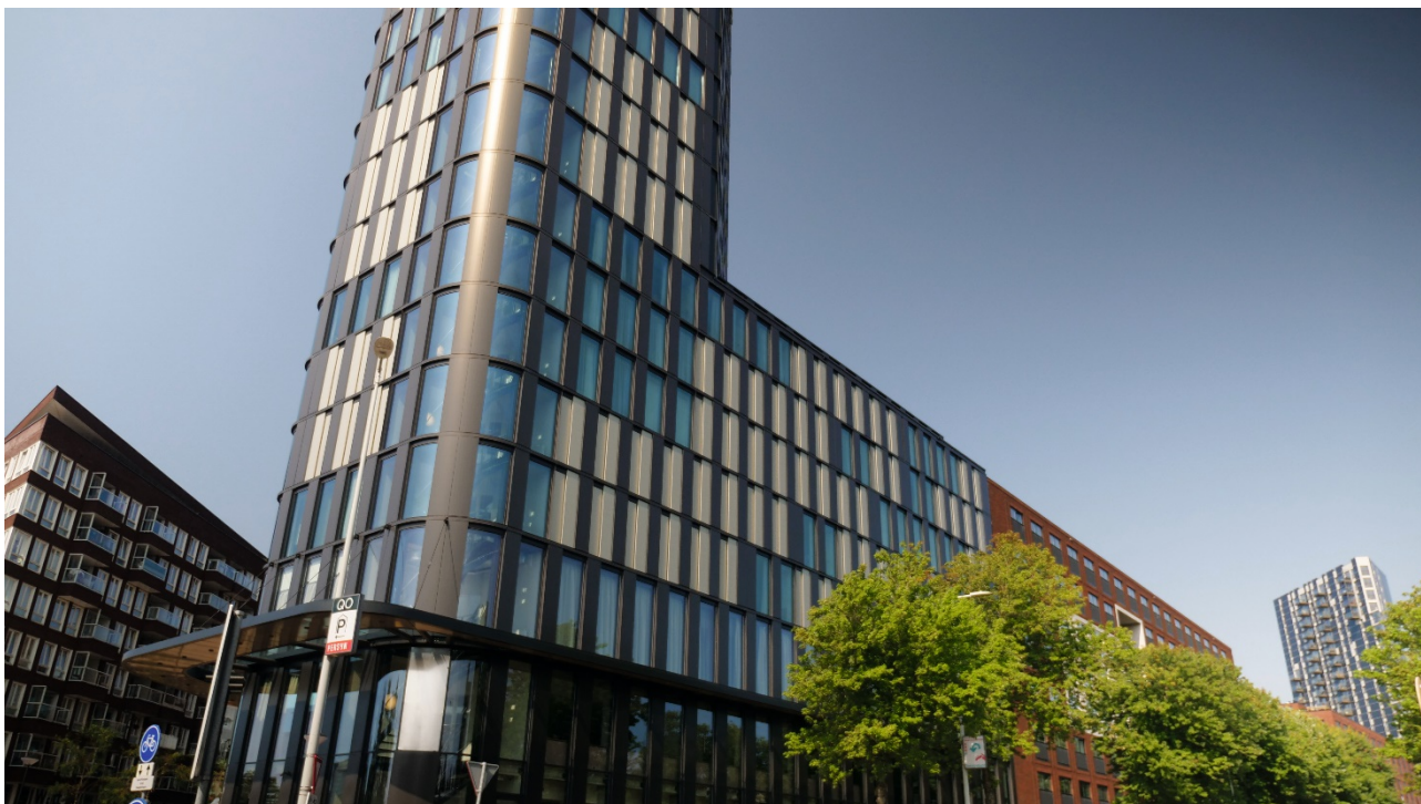
Afbeelding 1: Een essentieel onderdeel van het energie- en duurzaamheidsconcept is de 'levendige' gevel van glas en aluminium. Na zorgvuldig onderzoek bleek aluminium het duurzaamste materiaal te zijn. (Bron: HUECK)
