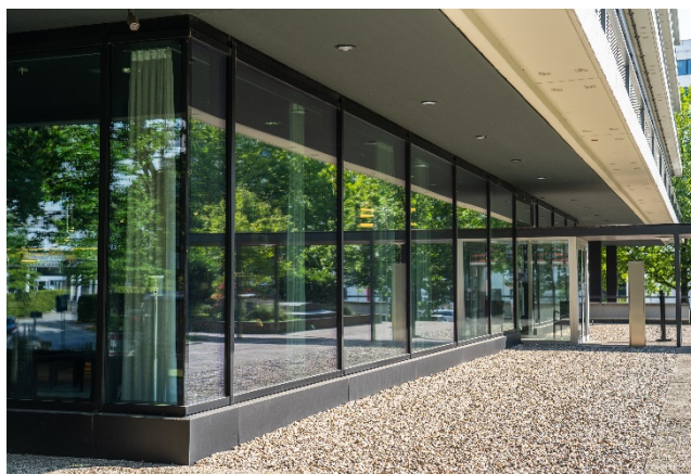
Afbeelding 3: De gevel werd op energetisch modern en statisch toereikend niveau nagebouwd met de oorspronkelijke aanblik met slanke profielen. (Bron: HUECK)
