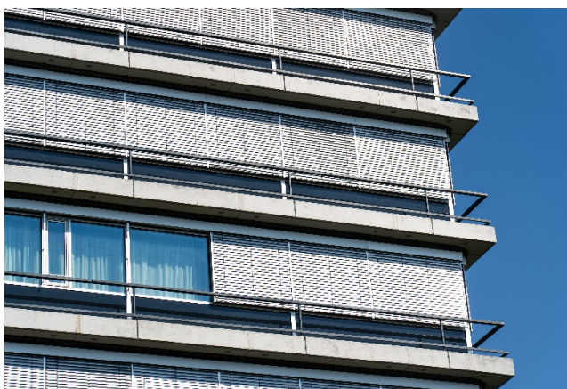
Afbeelding 2: Vanwege de vliesgevel met omlopend balkon die typisch is voor die tijd is het behoud van het gebouw zeer de moeite waard. Een bijzonderheid zijn de smalle aluminiumprofielen die de gevel structuur geven. (Bron: HUECK)
