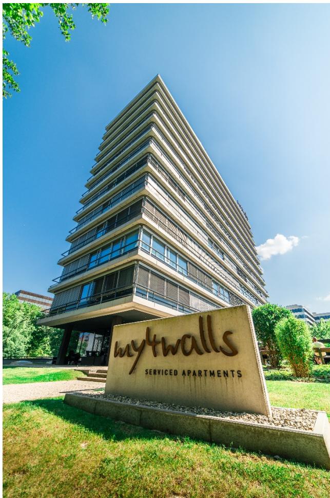
Afbeelding 1: In het stadsdeel City Nord van Hamburg kreeg het op de monumentenlijst geplaatste kantoorgebouw uit de jaren 60 een nieuwe bestemming, die voldoet aan de huidige eisen op het gebied van warmte-isolatie en brandbeveiliging. (Bron: HUECK)
