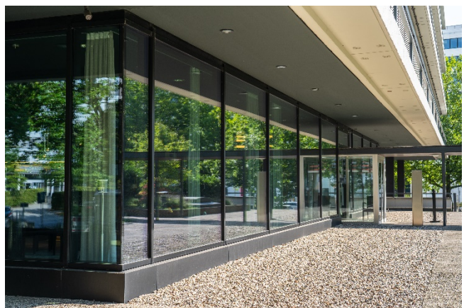
Abbildung 3: In der ursprünglichen Optik mit schlanken Profilen wurde die Fassade auf energetisch modernem und statisch ausreichendem Niveau nachgebaut. (Quelle: HUECK)
