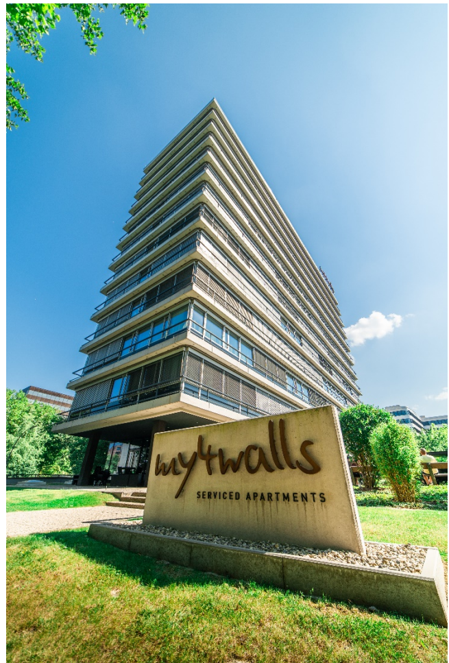
Abbildung 1: In der Hamburger City Nord ist eine Umwidmung des denkmalgeschützten 60er-Jahre Bürogebäudes entstanden, das modernen Ansprüchen an Wärmedämmung und Brandschutz gerecht wird. (Quelle: HUECK)
